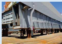
【ARを用いた出来形管理】
