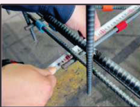
【立会状況（配筋確認：近接）】
