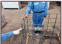
【立会状況（配筋確認）】
