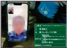
【立会状況（路盤出来形確認）】
