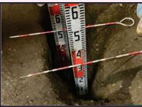
【立会状況（路盤出来形確認）】
