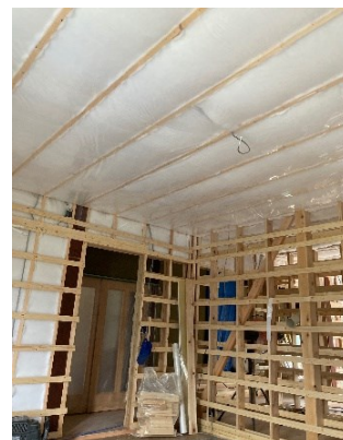
天井の改修風景
