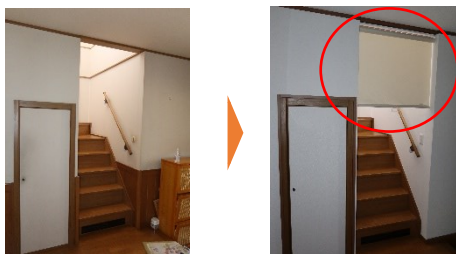
階段入口にロールスクリーンを設置
